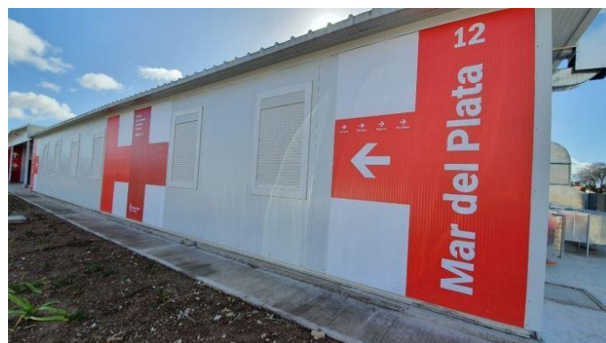
Figura 7: Hospital modular de emergencia instalado en Mar del Plata; junto al Hospital Interzonal General de Agudos (HIGA); durante la pandemia de COVID-19 como parte del Plan Federal de Hospitales Modulares de Emergencia (Ministerio de Obras Públicas / Ministerio de Salud de la Nación, Argentina).
